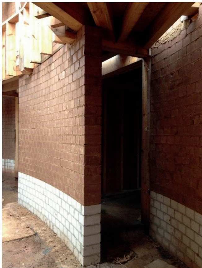
Bild 1 Lehmsteinmauerwerk mit einem Sockel aus Kalksandstein im Spritzwasserbereich, DRK-Kita Garz, Rügen
