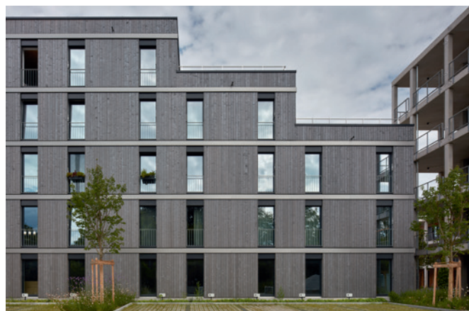
Bild 3 Holztafelaußenwände, geschosshoch vorgefertigt
