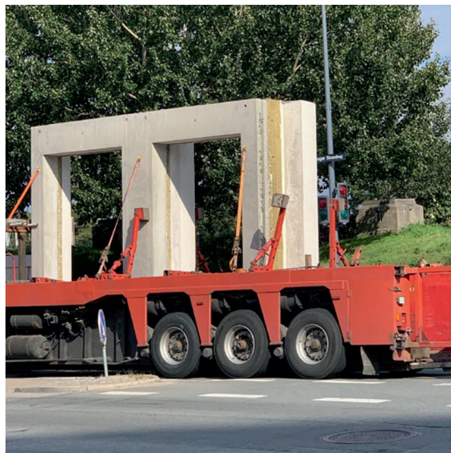
Bild 4 Schnappschuss von einem klassischen Betonfertigteil mit 30 cm mineralischer Dämmung
