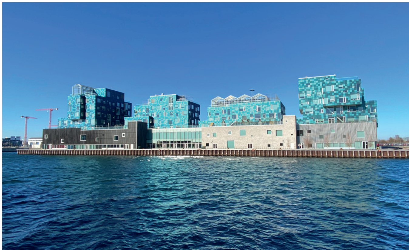
Bild 3 Internationale Schule in Nordhavn mit 12.000 gebäudeintegrierten PV-Paneeelen; Architektur: C. F. Møller
