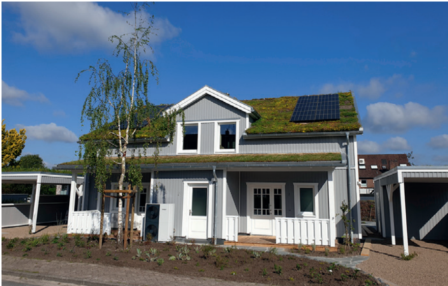
Bild 5 Ein Holzverschaltes Doppelhaus, dessen Holzrahmen mit Hanfsteinen ausgefacht wurde, Baujahr 2021, Niedersachsen
