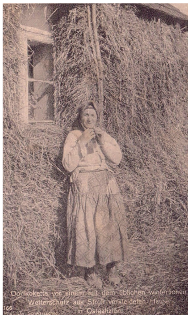
Bild 1 Bauernhaus in Ostgalizien mit Fassadendämmung aus Stroh, undatiert
