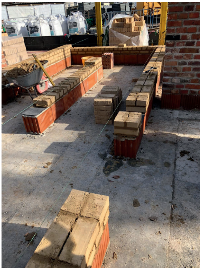
Bild 7 Foto von der Baustelle der Forschungshäuser in Bad Aibling, Ausführung der Treppenhauswände aus Lehmsteinmauerwerk
