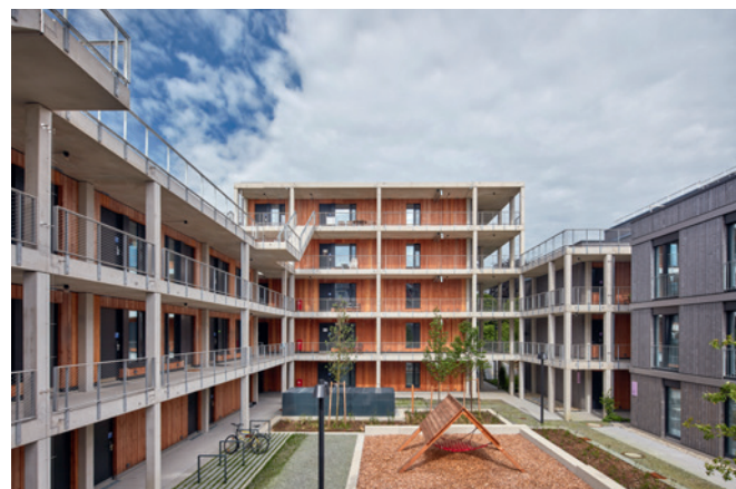
Bild 4 Blick in den Innenhof
